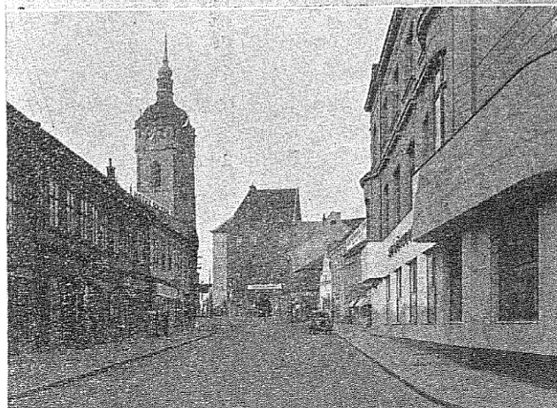
Obr. 14. Ul. Svatováclavská po úpravě 1934.
